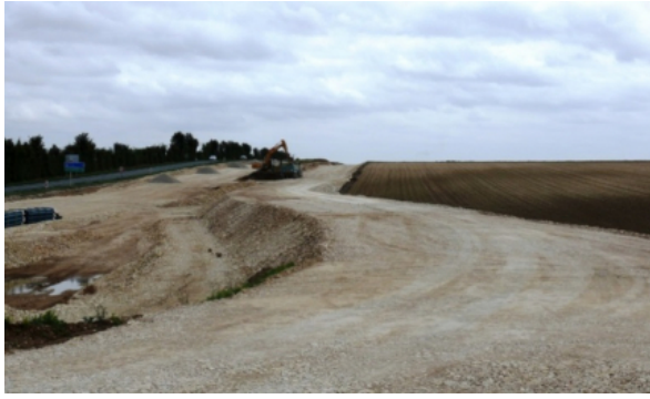
figure 13 - chantier d'autoroute stérilisant et déblayant des sols agricoles région de poitiers, france.
